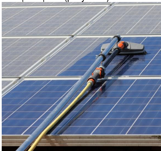
Рисунок 1 – Ручной способ удаления загрязнений
