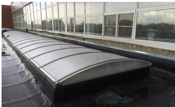
Рисунок 1- Вид зенитных фонарей–при строительстве.
