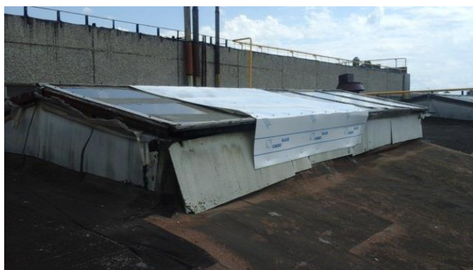
Рисунок 2- Вид образцов после 3-х летней эксплуатации зенитных фонарей.
